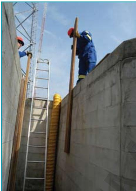
С рабочей стороны опустите вторую доску, на этот раз - на основание с рабочей стороны. Передайте её за верх на сторону ограниченного доступа и обоприте верхней частью на уже установленные щит и доску.
