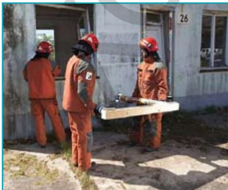
Это система из двух распорок с верхним и нижним упором по ширине проёма. Её следует собирать в безопасной зоне и после этого перемещать в нужное место.
