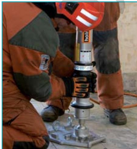
**З**акрепить – крепь раскрывается до требуемых размеров и фиксируется по месту.
