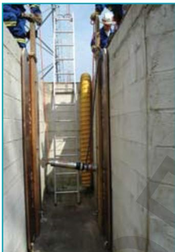
При помощи веревок опустите первую крепь к низу провала на расстояние 0.6 м / 2 фт. от дна. После этого раздвиньте крепь и зафиксируйте положение, используя соответствующую систему.
