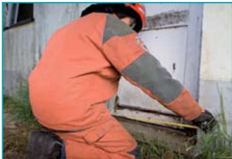
Сначала примерно измерьте ширину проёма.
