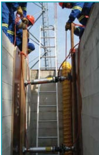
То же самое делается для крепи сверху. Её следует расположить на высоте не ниже 0.6м / 2 фт. от края провала.
