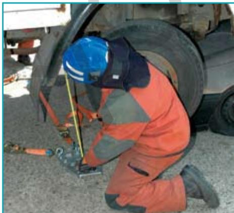
Чтобы использовать максимально удлинение распорки для подъёма, сделайте предварительно примерные измерения требуемой длины крепи.
