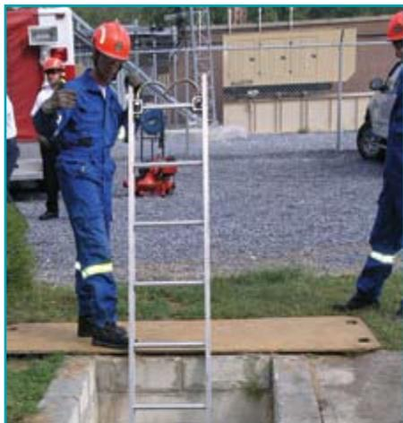
После установки лестницы в передней части провала попросите покинуть провал тех, кто может двигаться.
