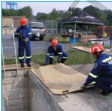
В то же время другие члены спасательной команды должны класть опорные щиты (доски) по краю провала, чтобы распределить вес спасателей, которые будут здесь работать.
