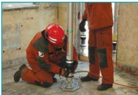
Крепь раздвигается и её длина фиксируется системой фиксаторов.
