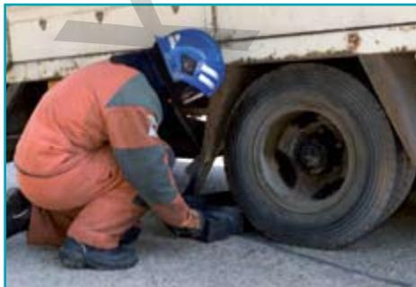
Перед подъёмом груза ещё раз проверьте состояние заклиненных колёс, стоящих на земле. Также необходимо по всему периметру следить за любыми движениями груза во время подъёма.
