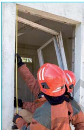
После установки брусьев в проём измерьте длину требуемых крепей.
