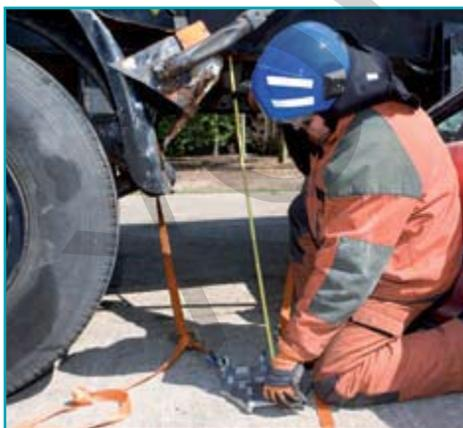
При сборке крепей сначала примерно оцените требуемый размер. Это поможет спасателям максимально использовать раздвижение распорки для дальнейшей её регулировки.
